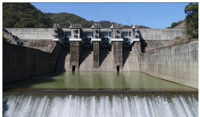
（石河内ダム全景）
