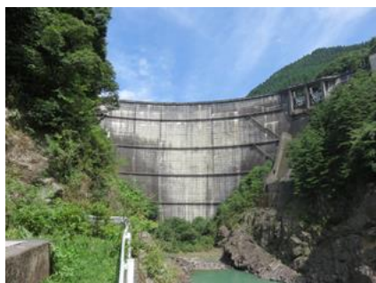
(上椎葉ダム全景)
