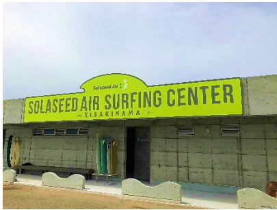
ソラシドエアサーフィンセンター木崎浜 外観
